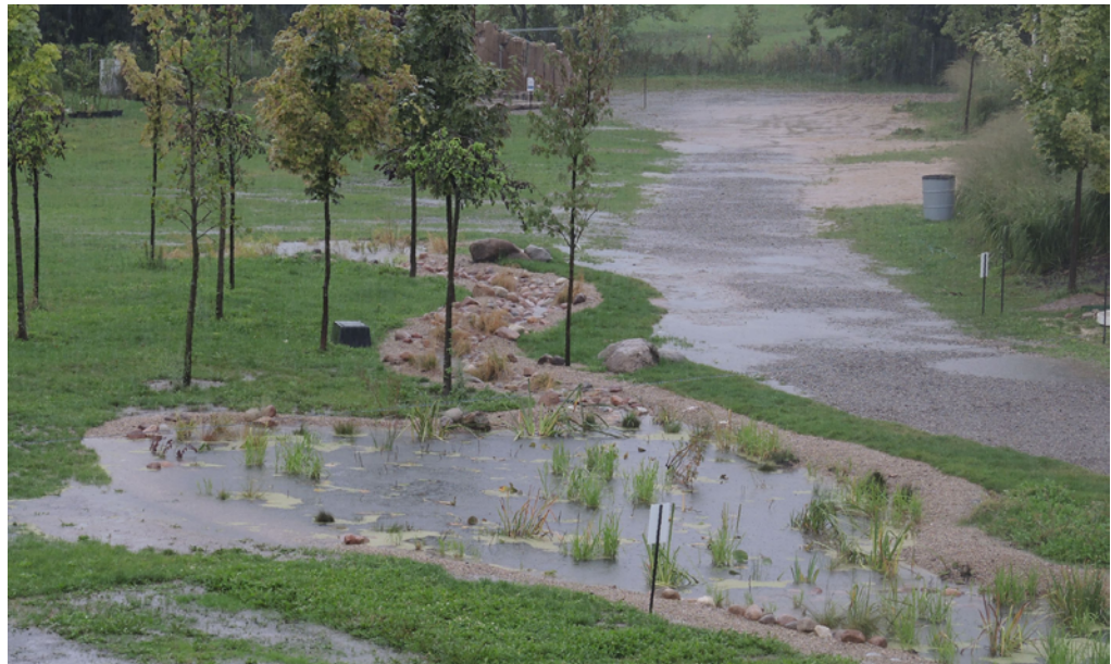
Ryc. 23. Ogród deszczowy podczas intensywnych opadów – przykład Rozwiązania opartego na przyrodzie. Widoczna niecka zbierająca wodę oraz odprowadzenie wody na trawnik. Ogród założony przez Fundację Krajobrazy na terenie Browaru Perła w Lublinie, fot. J. Kamiński
