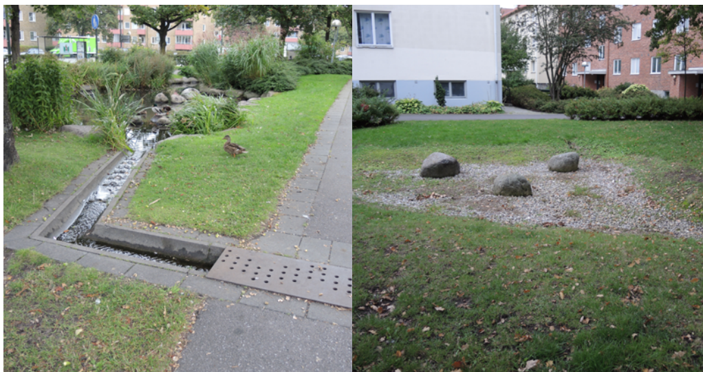
Ryc. 19. Osiedle Augustenborg w Malmö, Szwecja, przykłady elementów wdrażających koncepcję BZI, zbiornik retencyjny z kanałem doprowadzającym wodę deszczową i sucha niecka retencyjna, fot. J. Kamiński
