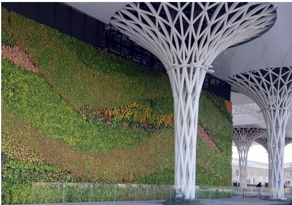
Ryc. 25. Zielona ściana Dworca Lublin, rozwiązanie wymagające intensywnej pielęgnacji, w mocno zurbanizowanej przestrzeni pełni ważną rolę społeczną, zwiększa komfort przebywania w przestrzeni i wpływa na wizerunek miasta, fot. J. Renda
